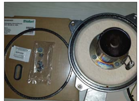
Obr. 6 Výměna těsnění spalovací komory s použitím originálního náhradního dílu
