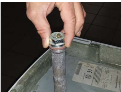
Obr. 7 Kontrola ochranné ochranné tyče v zásobníku teplé vody
